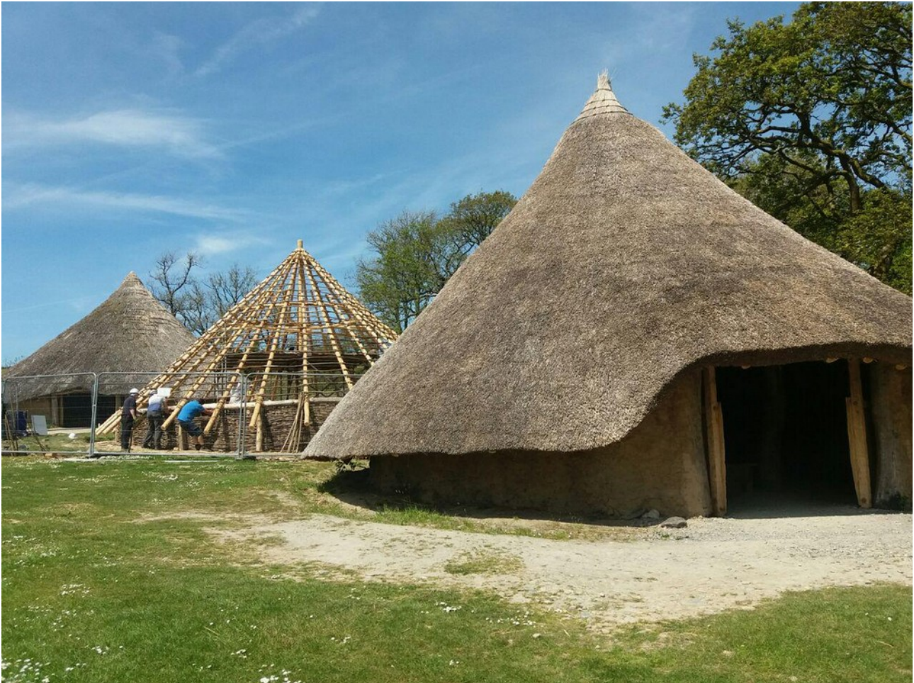
Kuva: Keskimmäisenä rakentamamme rautakautisen talon ranko, johon myöhemmin rautakautiskylän omat työntekijät rakentavat saviseinät ja korsikaton.
