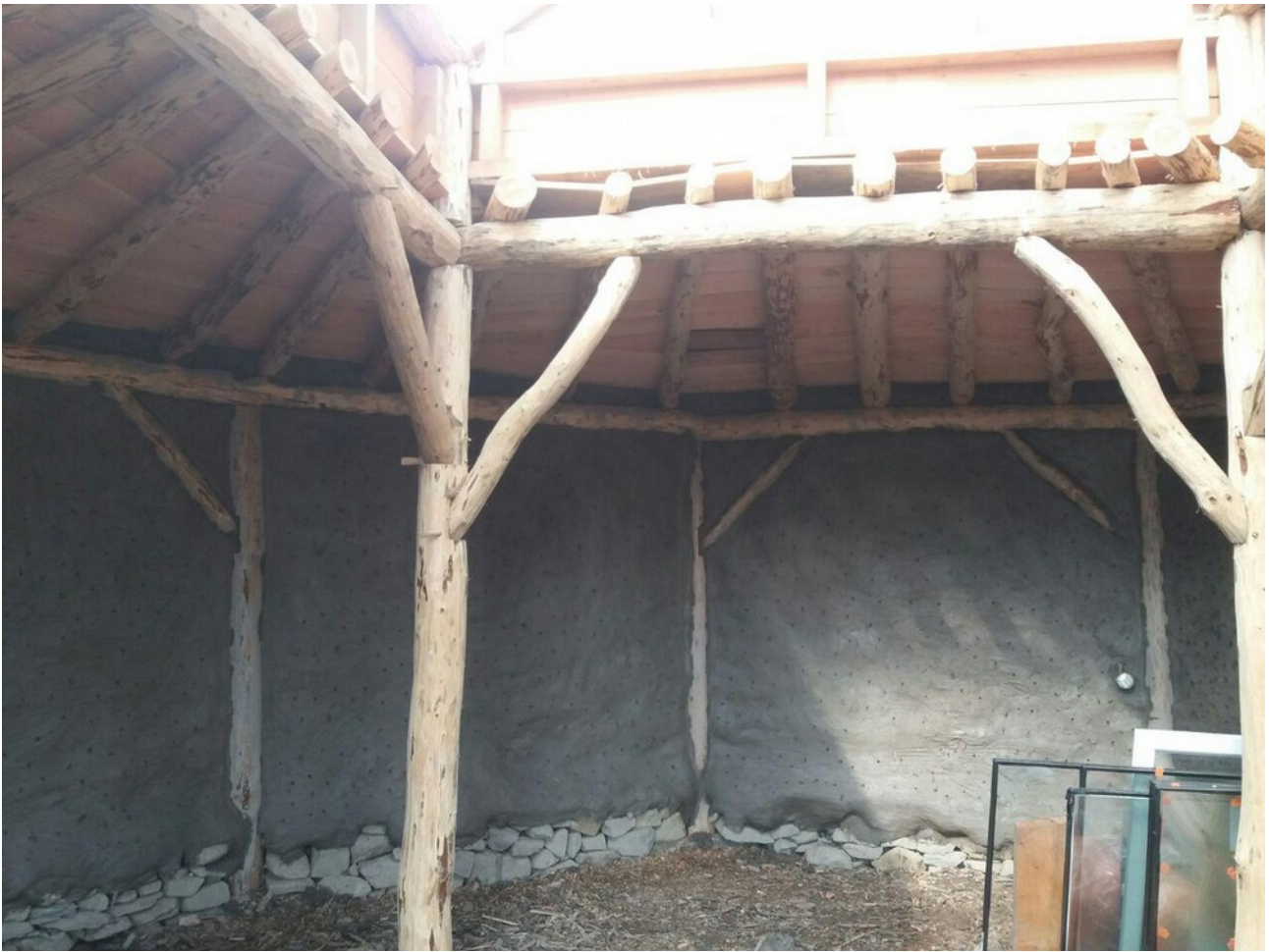
Kuva: Timber frame -rakentamisessa voidaan hyödyntää myös mukavia kurvikkaita puukappaleita, joita ei muuten rakentamisteollisuudessa usein voida hyödyntää
